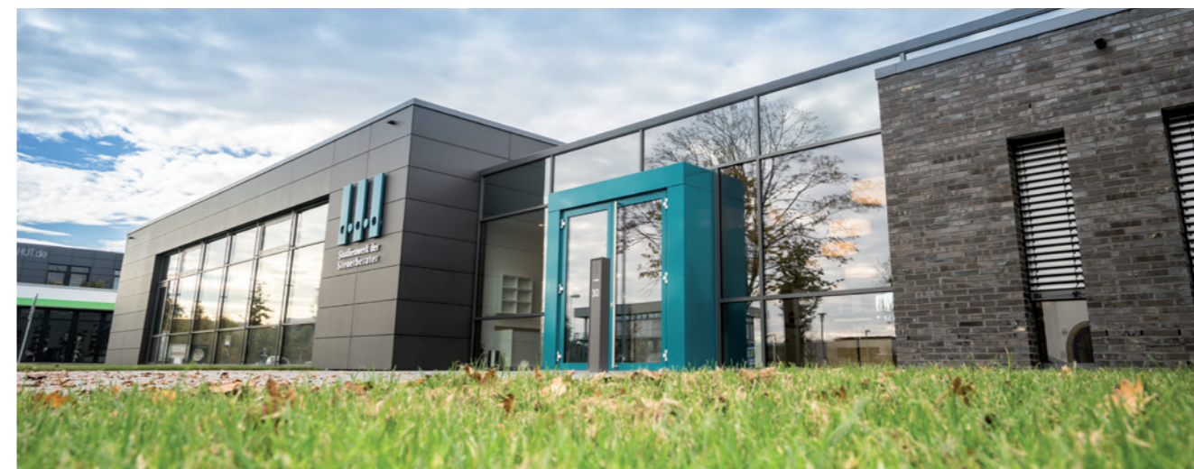
Studienwerk Schulungsgebäude Münster
